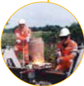
Soudure aluminothermique de rail
